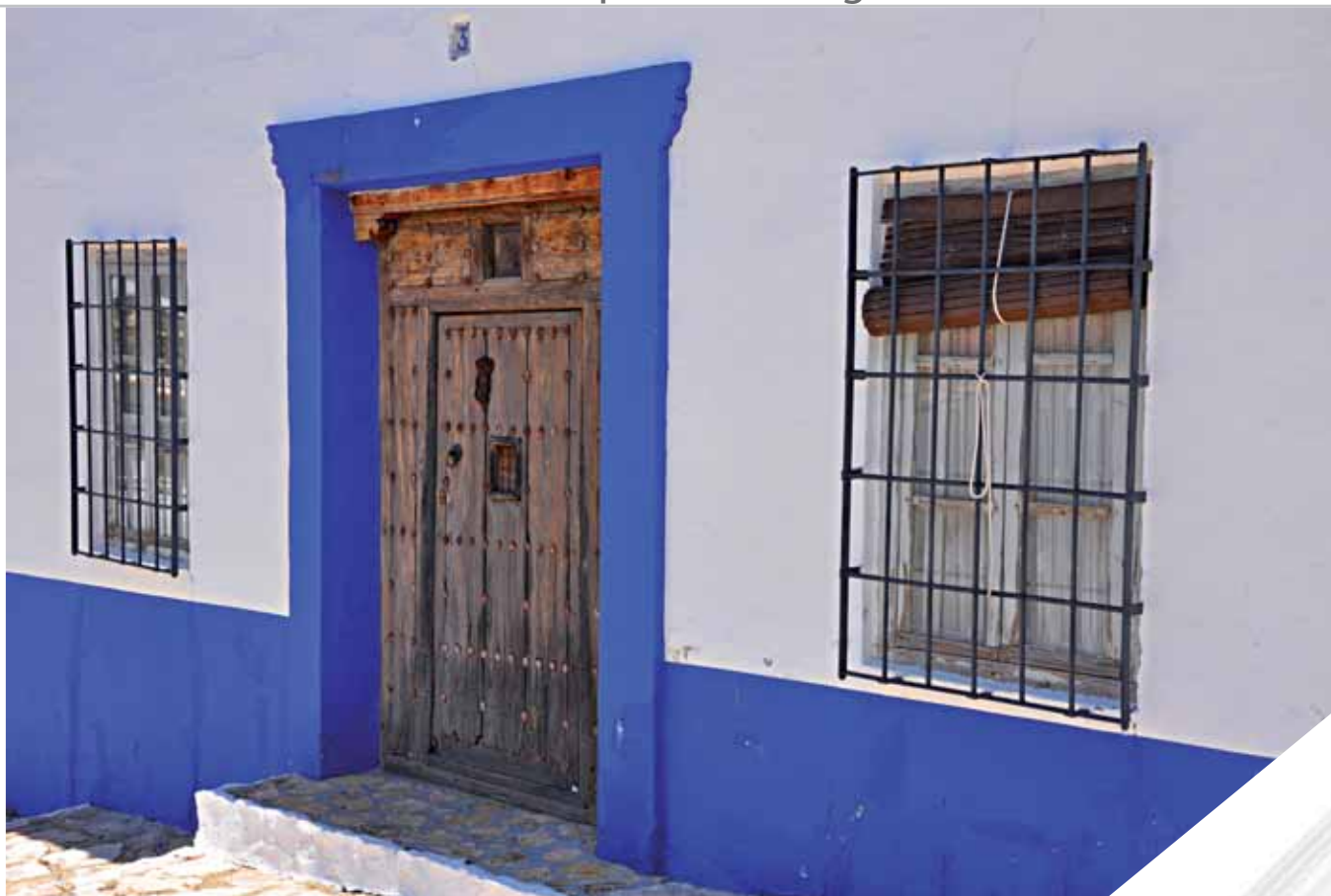
FACHADA DE CASA TÍPICA MANICHEGA
