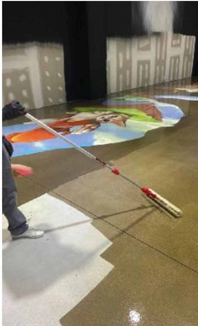
Dans ce cas, il s'agit de rouleaux en polyamide texturée, plus grands que les conventionnels pour couvrir une surface plus importante.
